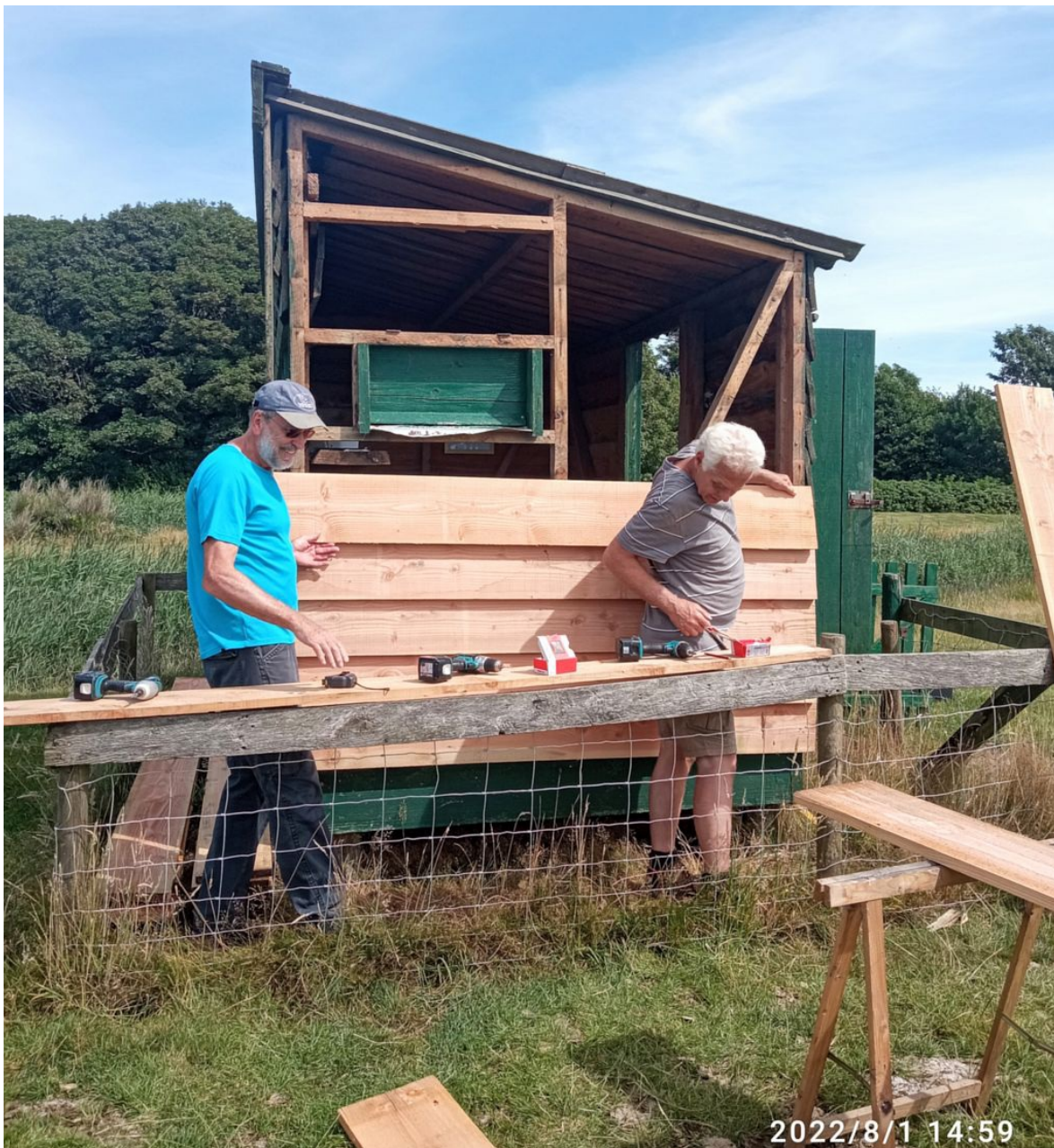
Onderhoud aan de Wilster, Dijkmanshuizen
